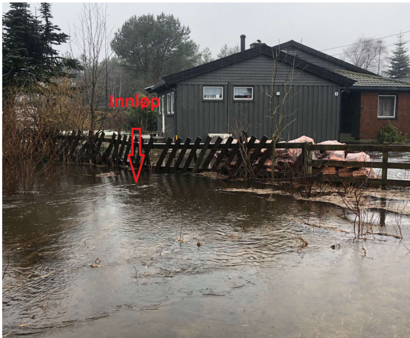
Figur 4. Innløp kulvert 4, dykket.
