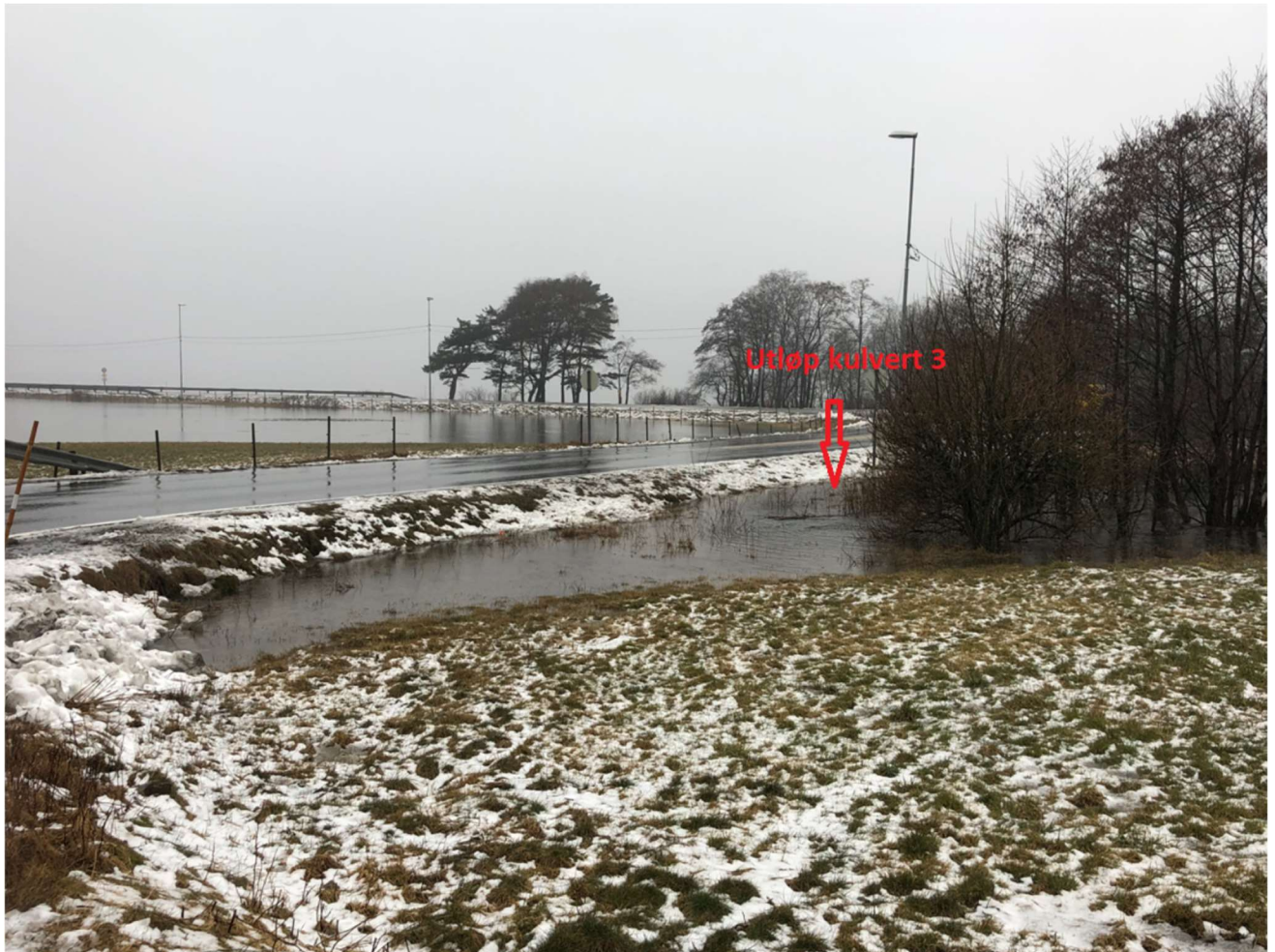
Figur 5. Utløpet av kulvert 3, dykket.
